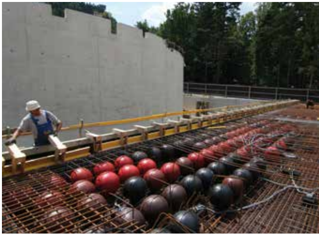
Abb. 3: Einbau der Cobiaxdecke
