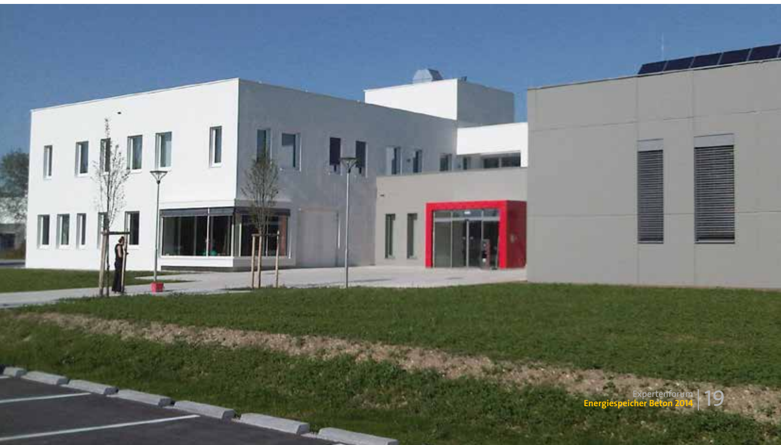
Abb. 1: Das neue Betriebsgebäude
