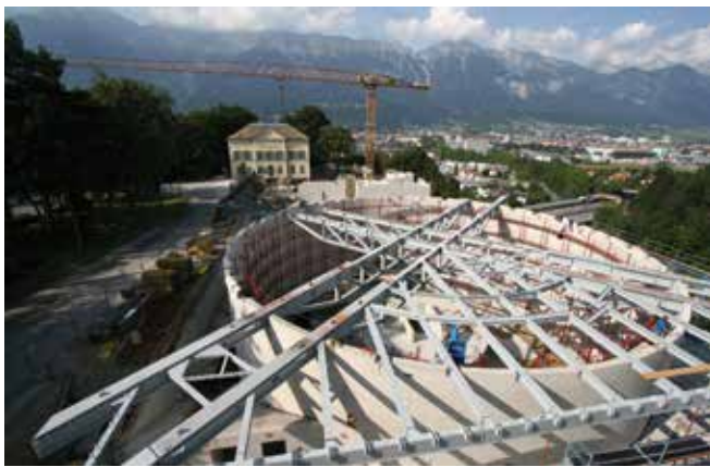
Abb. 5: Zylinder mit Tragwerk Fotos: © stoll.wagner ziviltechnikergesellschaft mbh
