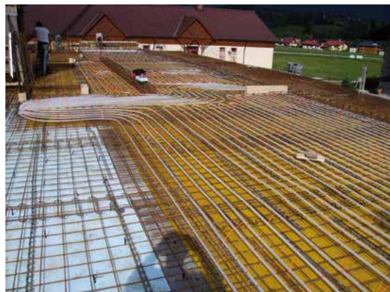
Abb. 2: Die Verrohrung erfolgt einfach auf der unteren Bewehrung
