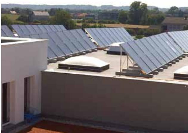
Abb. 3: Warmwasser-Solaranlage
