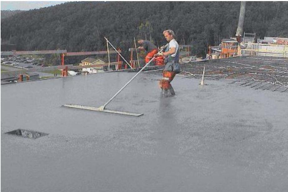
Abbildung 11.2: Abziehen von SCC mit einem Abziehbrett
